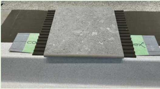
Abdichtung GFK-Becken mit codex X-Terra 200, codex Dichtband
